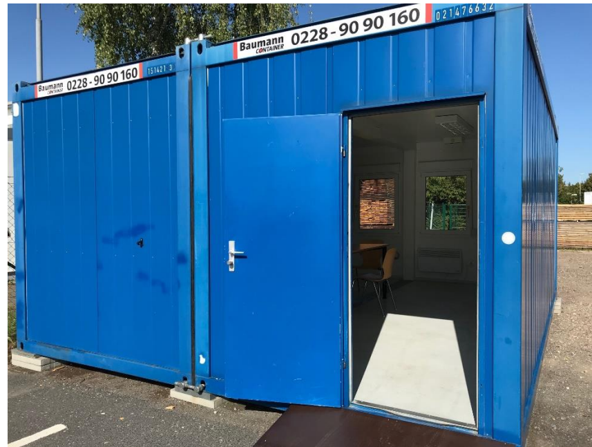
Beispiel: Räumliche Entzerrung durch Bürocontainer
