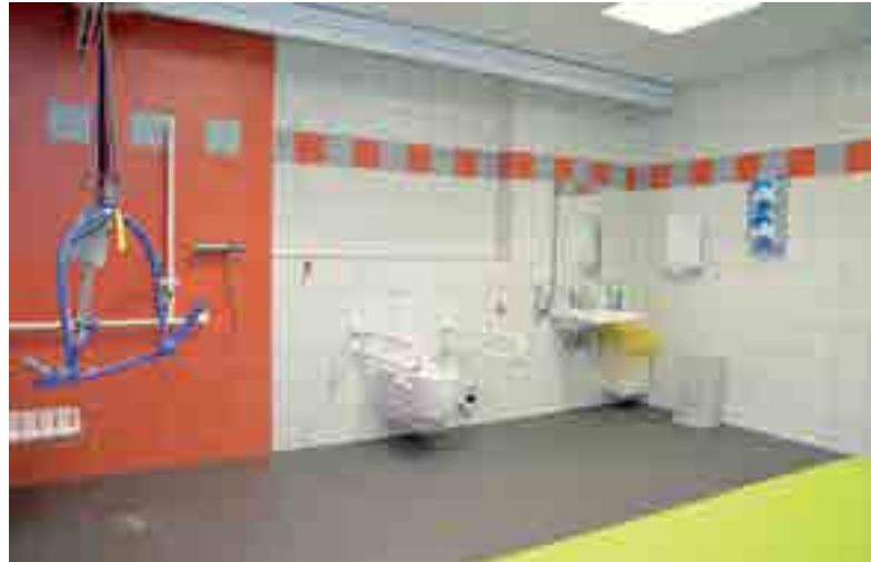
So wie hier in Werk 1 werden die neuen Sanitärräume in Werk 2 auch bald aussehen
