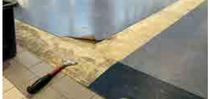
Der Fußboden wird abgetragen
